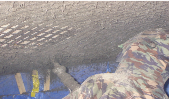
写真-2 下面増厚吹付け施工状況
