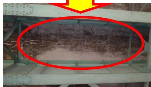
写真-1 施工前床版の状況
