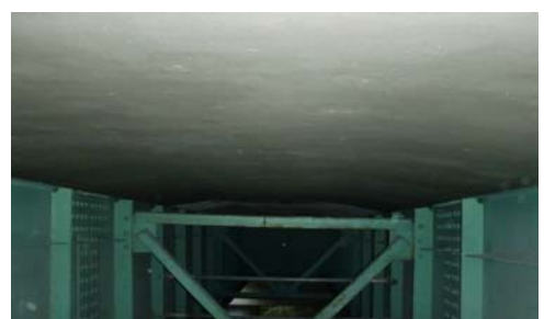
写真-2 増厚補強施工後床版の状況
